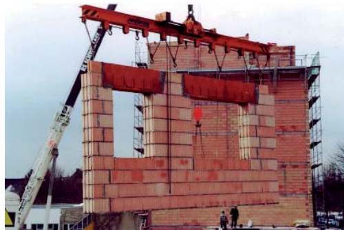
Abb. 7: Verarbeitung von Wandtafeln aus Ziegeln. Bildquelle: Bundesverband der Deutschen Ziegelindustrie, Bonn
