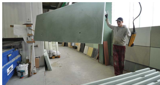
Abb. 8: Bauteile aus Beton werden witterungsunabhängig im Werk vorgefertigt und auf der Baustelle nur noch zusammengesetzt. Bildquelle: © BetonBild
