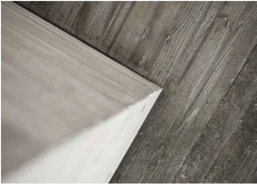
Abb. 15: Bei Sichtbeton können die Ansichtsflächen gestalterische Funktionen übernehmen. Die Optik der Flächen wird durch die Schalungshaut bestimmt. Bildquelle: © BetonBild
