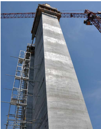
Abb. 4: So manche kühne Konstruktion ist ohne Beton nicht realisierbar Bildquelle: © BetonBild
