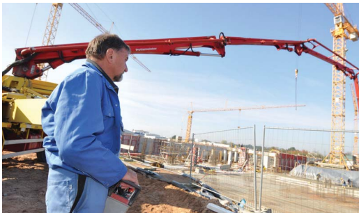
Abb. 11: Betonpumpe im Einsatz. Bildquelle: © BetonBild
