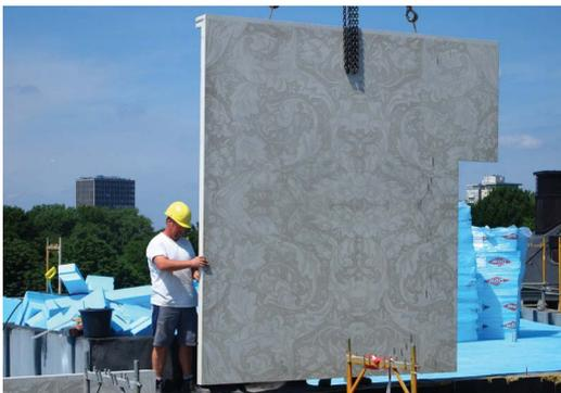
Abb. 6: Montage von Wandelementen aus Beton.
