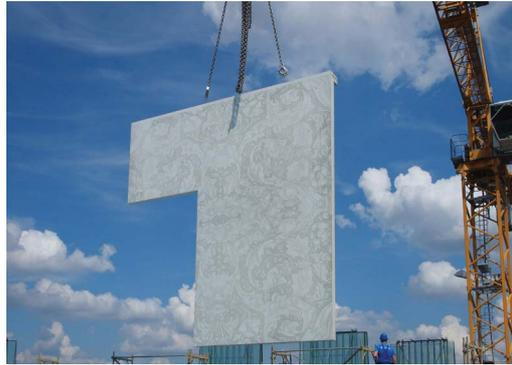
Abb. 4: Montage von Wandelementen aus Beton. Wirtschaftlichkeit und Schnelligkeit einer Montagebaustelle sind in hohem Maß vom Grad der Vorplanung und einer gut funktionierenden Logistik abhängig.
