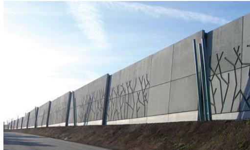
Abb. 3: Montage von Lärmschutzwänden aus Leichtbeton-Elementen.
