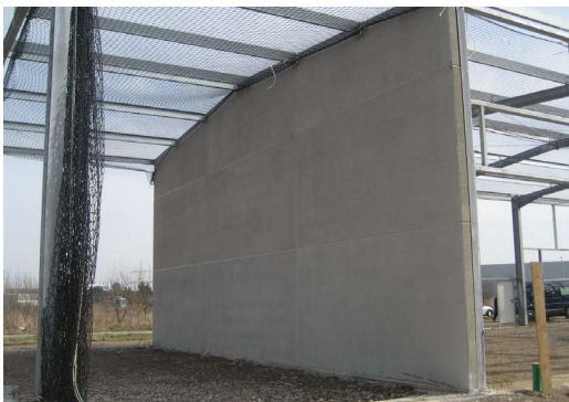
Abb. 1: Vorgefertigte Wandelemente aus Leichtbeton gibt es als tragende und nichttragende Systeme.
