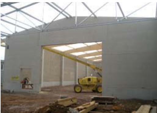
Abb. 6: Die Herstellung von Leichtbeton-Elementen erfolgt im Fertigteilwerk entsprechend den Vorgaben der Bauwerksmaße unter idealen Bedingungen. Für den Bauunternehmer bietet die Montage auf der Baustelle erhebliche Einsparpotenziale.
