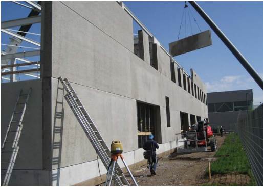
Abb. 5: Systeme aus Leichtbeton-Elementen sind so flexibel, dass die architektonische Gestaltungsfreiheit voll erhalten bleibt.
