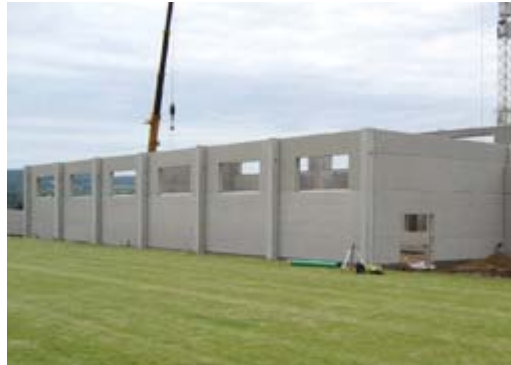
Abb. 4: Die Elementbauweise mit Leichtbeton-Elementen bietet Vorteile durch kürzere Bauzeiten und eine verbesserte Bauqualität.
