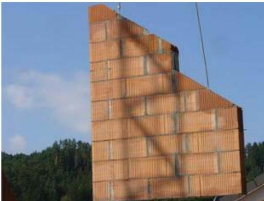
Abb. 1: Mauertafeln aus Ziegeln sind vorgefertigte Mauerwerkselemente, die entsprechend der individuellen Planung exakt nach Maß gefertigt werden.
