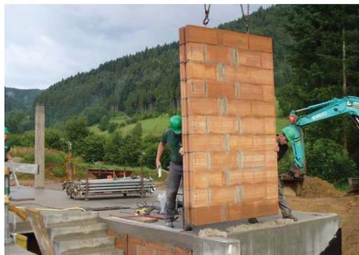
Abb. 5: Die Elemente werden vorsichtig in das vorbereitete Mörtelbett mit den höhengerecht ausgerichteten Nivellierplättchen gesetzt und ausgerichtet.
