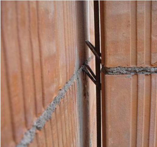
Abb. 6: Die Verbindung der einzelnen Mauertafeln untereinander erfolgte durch stumpfen Stoß.
