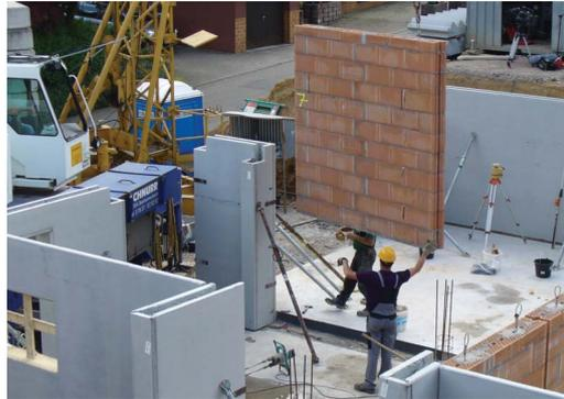
Abb. 4a, b: Das Versetzen der fertigen Elemente erfolgt entsprechend der im Montageplan angegebenen Reihenfolge mit Hilfe eines Baustellen- oder Autokrans.
