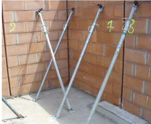
Abb. 8: Bis zum Aushärten der Mörtelschicht und der oberen Aussteifung der Gesamtkonstruktion wurden die Wandelemente gegen Windsog und Winddruck durch Montagegestreben gehalten, die nach dem lotrechten Ausrichten der Wand zug- und druckfest arretiert wurden.
