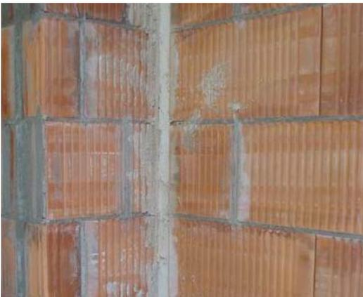
Abb. 7: Die Stoßfugen wurden mit Mörtel verfüllt. Diese schnelle Montage bewirkt, dass nur geringe Baufeuchte in den Rohbau eindringen kann. Lange Austrocknungszeiten entfallen damit.
