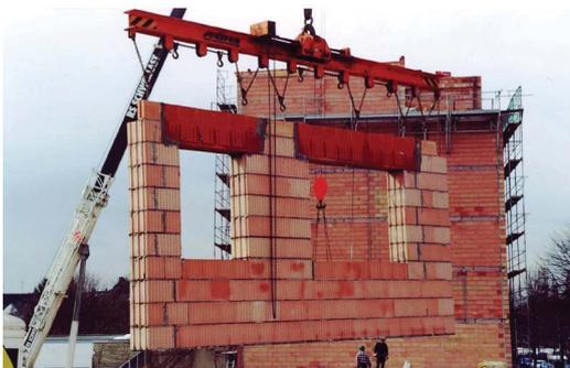
Abb. 9: Versetzen einer Ziegelwand.
