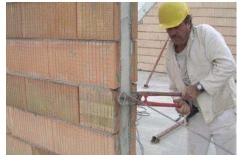
Bild 13: Entfernung der Transportbewehrung
