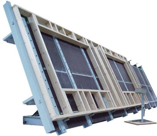
Nachdem der Holzrahmen erstellt und die Dampfsperffolie aufgelegt ist, wird die Beplankung aufgelegt, geklammert und zugeschnitten.
