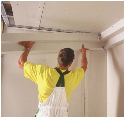
Abb. 7: Durch Vorfertigungen mit Gehrungsschnitten können auch Übergänge in Wandecken schnell und exakt ausgeführt werden. Foto: Lafarge Gips GmbH
