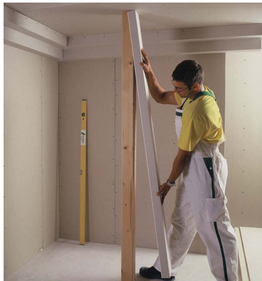
Abb. 9: Stützen- und Trägerbekleidungen in Faltechnik. Foto: Lafarge Gips GmbH
