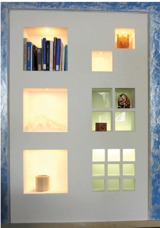
Abb. 2: Mit Gipskartonplatten können auch ausgefallene Formen schnell und einfach in Trockenbauweise realisiert werden.
