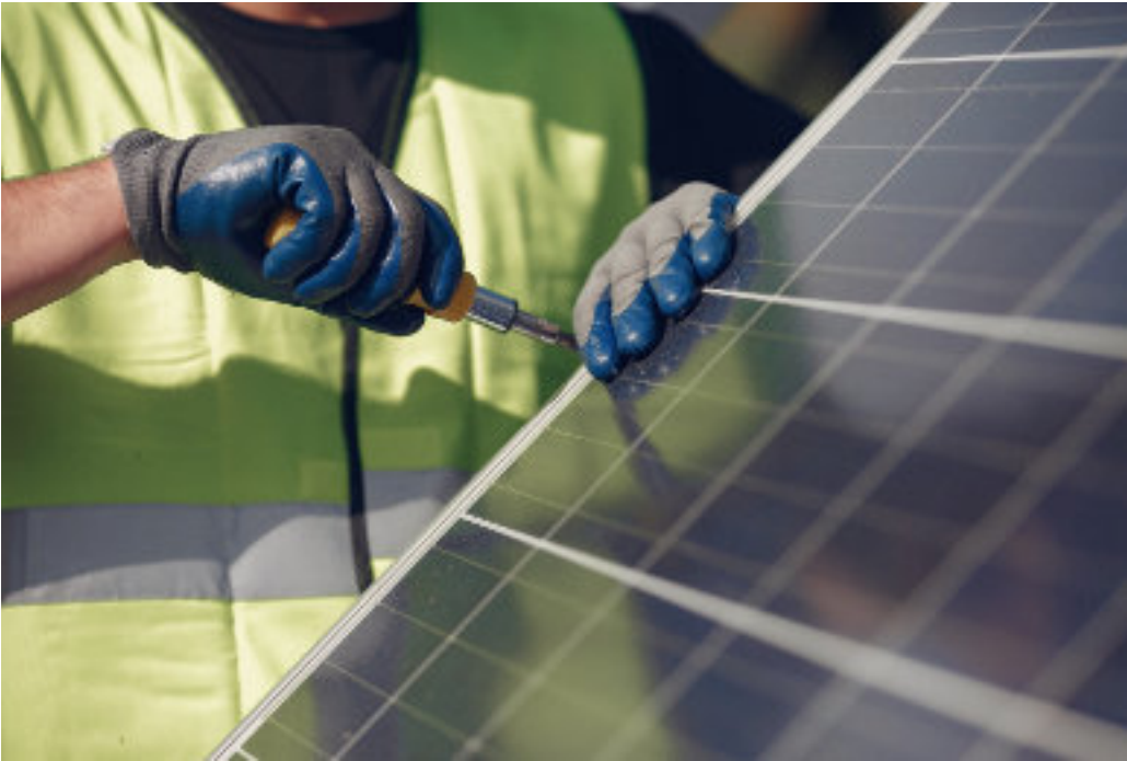
Montage einer Photovoltaikanlage (Foto: Alex Csiki auf Pixabay)
