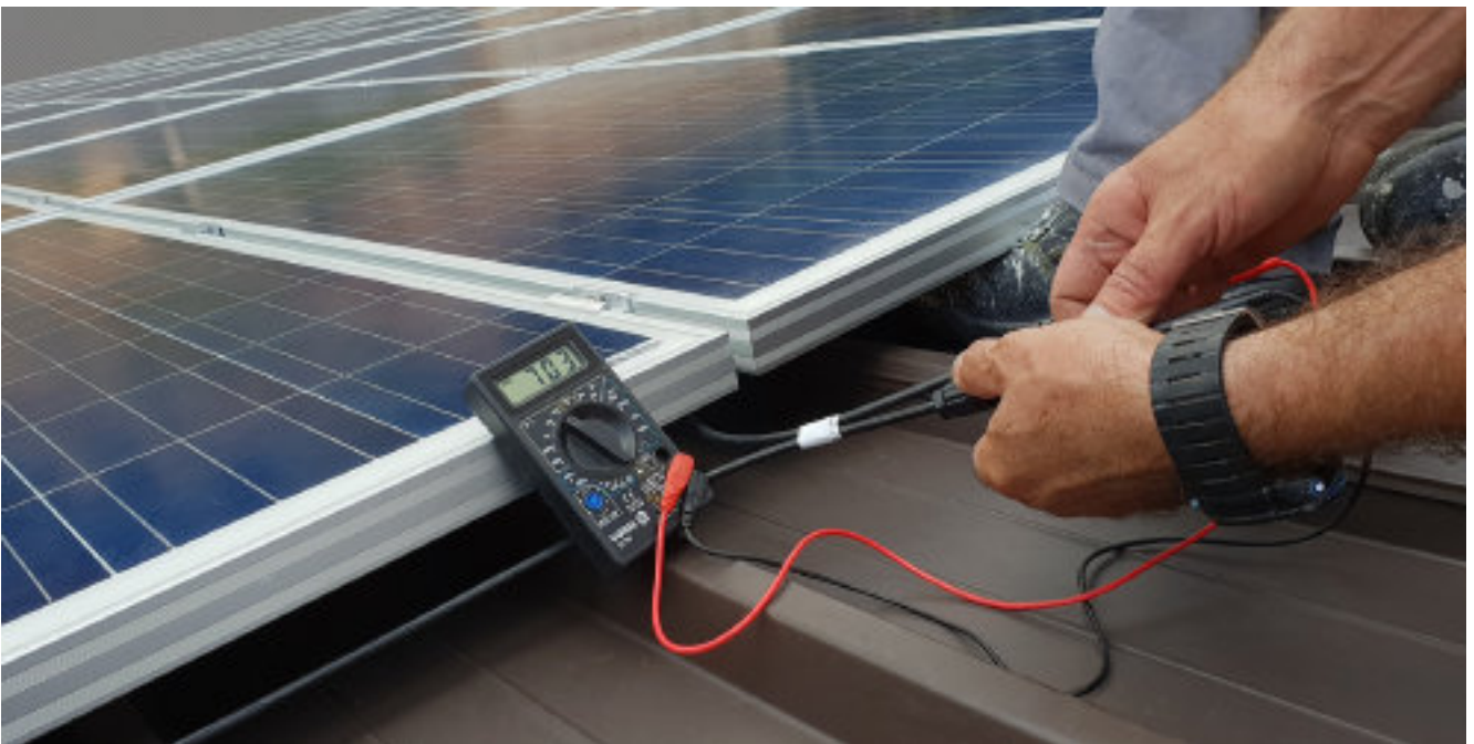
Funktionsprüfung einer Photovoltaikanlage (Foto: Comouna Reina auf Pixabay)
